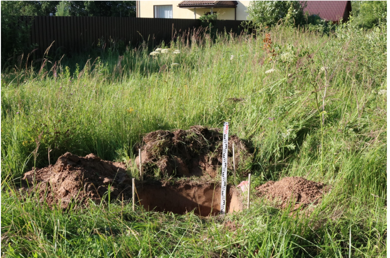
Рис. 45. Археологическое обследование по объекту: «Уличные газопроводы дер. Константиново Малоярославецкого района». Калужская область. 2023 г. Шурф 4. Общий вид с Ю после завершения работ.
